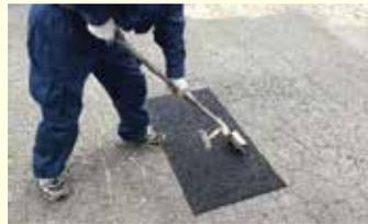
路面貼付後、丁寧に足踏みするか、手押しローラ、タンバ、木槌などでマット表面に満遍なく圧力を加え路面と密着させる。
