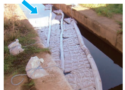
土のうでも支点になります。
